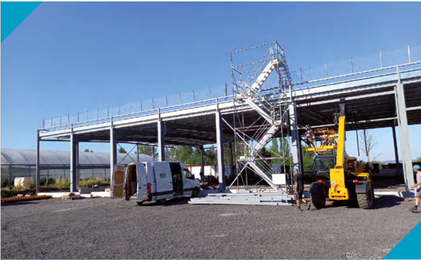
ESAT Le Village : chantier de construction de la menuiserie
