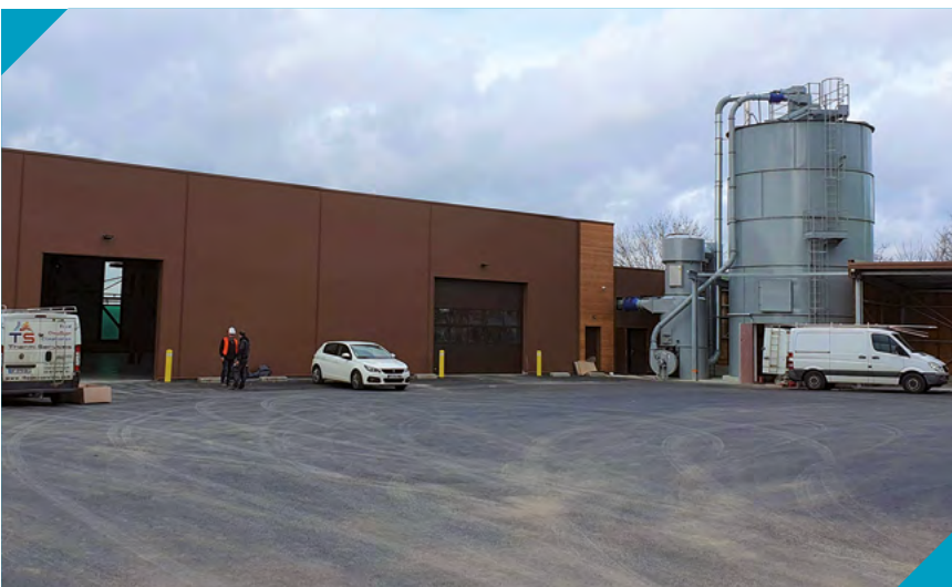
ESAT Le Village : La cour et le silo alimentant la chaudière
